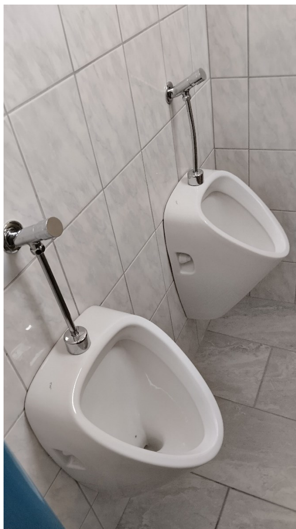
Generální oprava chlapeckých WC, stav před a po
