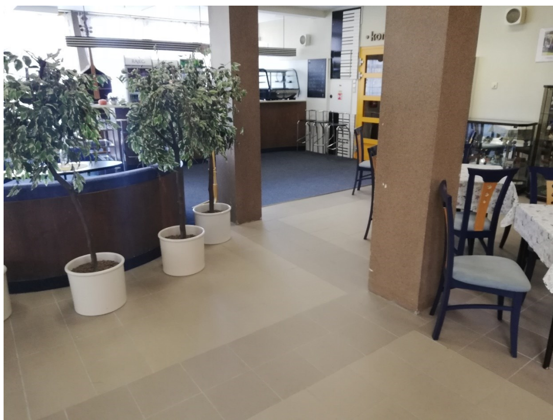
Detail opravené dlažby v prostorách bufetu
